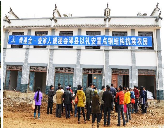
图为壹基金援建会泽县以礼安置点钢结构抗震农房
