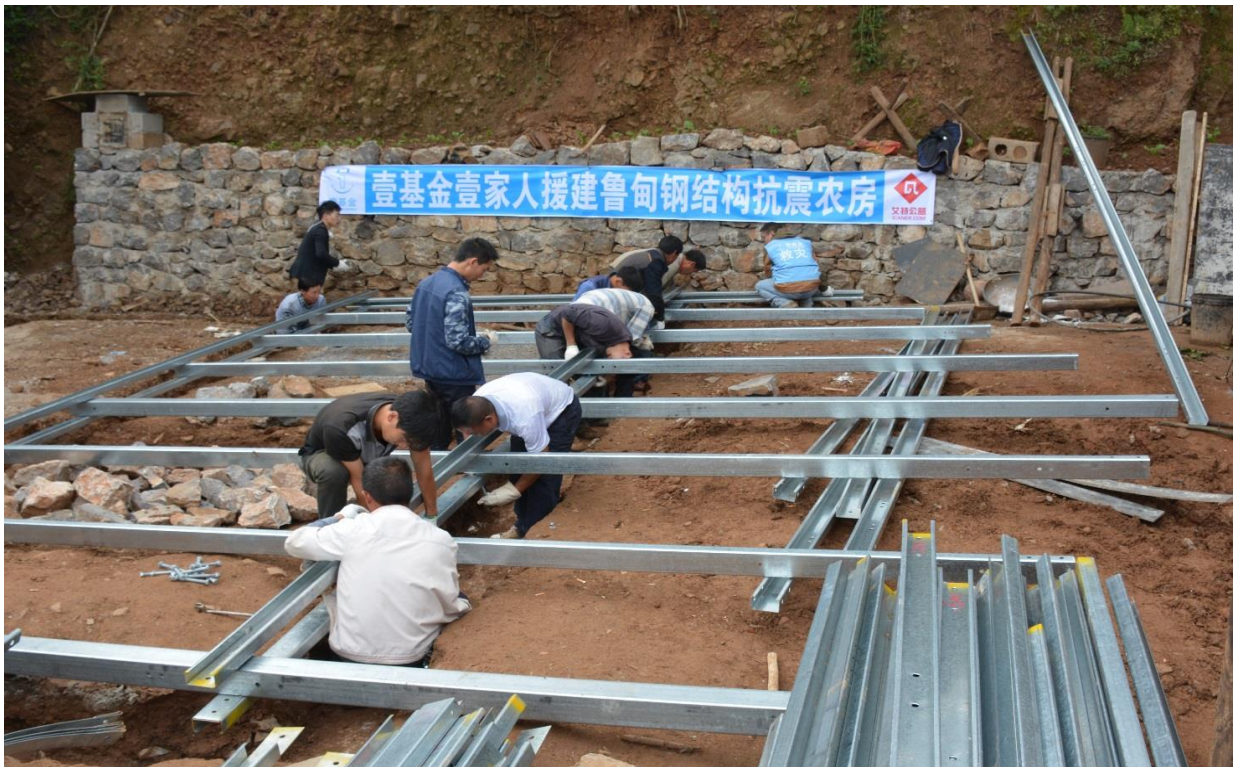
图为壹基金援建鲁甸钢结构抗震农房
